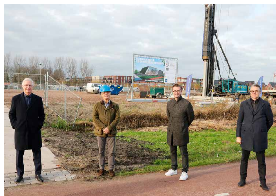
Het bouwspandoek is onthuld, v.l.n.r. wethouder Albert Koning, Joop Veerman (van St. Mauritius), wethouder Vincent Tuijp en Jack Steur (van Kuiper Steur Architecten BNA).
